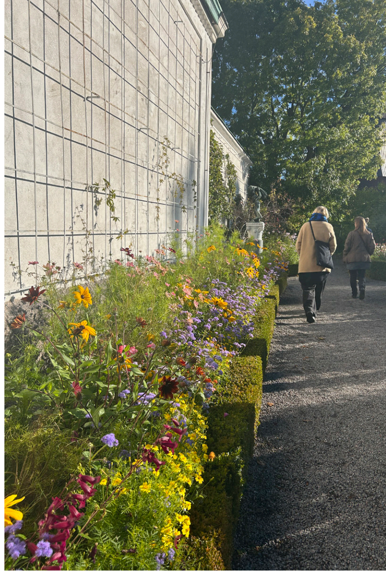
Figur 25. Galleriets södra fasad har klätts med en spaljé för klängväxter. Foto: Pernilla Lindström.
